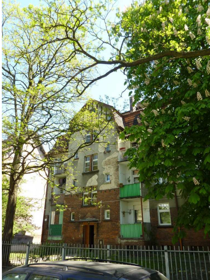
Fot. 1 Budynek wielorodzinny przy ulicy Kolejowej 18 w Poznaniu.
