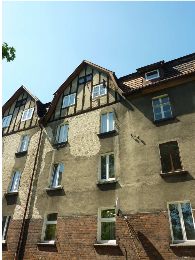
Fot. 3 Elewacja tylna – wschodnia (od podwórza)
