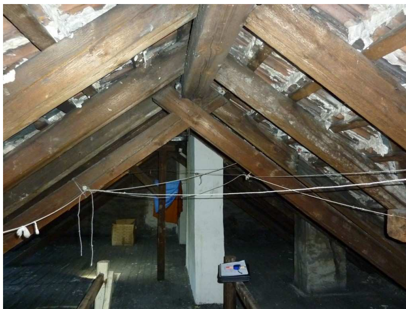
Fot. 2 Widok na płatew kalenicową oraz podparcie płatwi.
