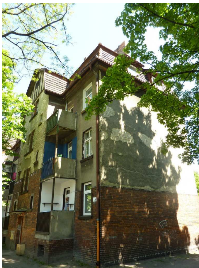
Fot. 2 Elewacja południowa - szczytowa
